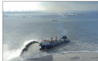
▲ Maasvlakte 2 wordt opgespoten met zand van de Noordzeebodem. (Aeroview-Rotterdam)
