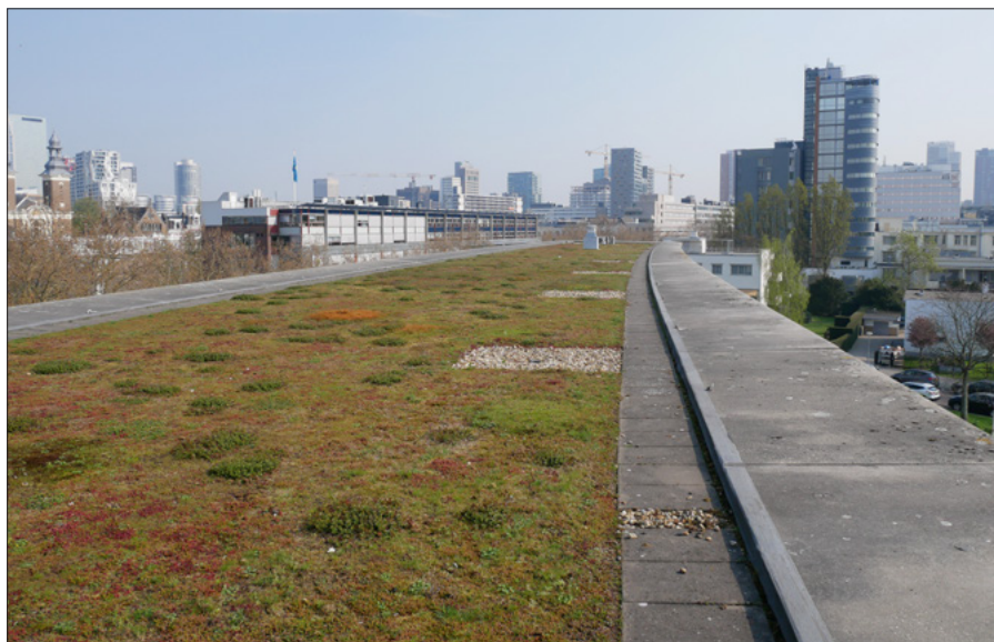
▲ Het groene dak van Het Nieuwe Instituut is voorzien van een mat met Sedum . Museumpark, Rotterdam. (Marco Tanis)
